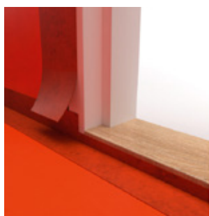
BILD E - Tröskel i liv med vägg Försegling ska utföras kontinuerligt mellan tröskel, karm och vägg. I våtzon 2 krävs inte försegling på karm.
